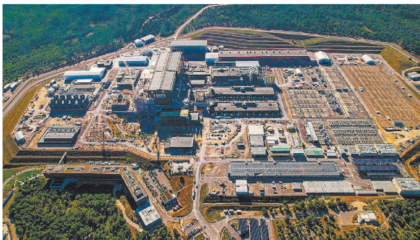
Площадка ИТЭР (вид сверху)
