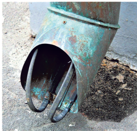
Рис. 3. Осторожнее с этой трубой
