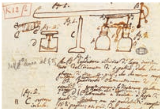
Рис. 2. Эскизы инструментов, которыми пользовался Алессандро Вольта в экспериментах с лягушками. Мемуар о животном электричестве, 14 мая 1792 года (Архив А.Вольты, лист K13, Ломбардская академия наук и литературы)
